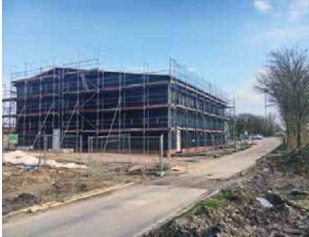
Baufortschritt an der neuen Filterhalle
