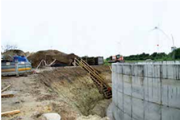
Neubau der Ortsentwässerung in Wittbek
