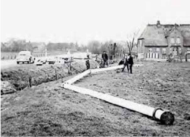
Bau des Rohrnetzes auf Nordstrand
