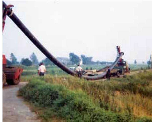
Transport des Dükers von Ohrstedt über Land zur Treene
