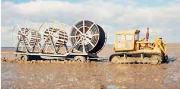
Einpflügen der Wattleitung von Fuhlehörn auf Nordstrand nach Hallig Südfall, 1995
