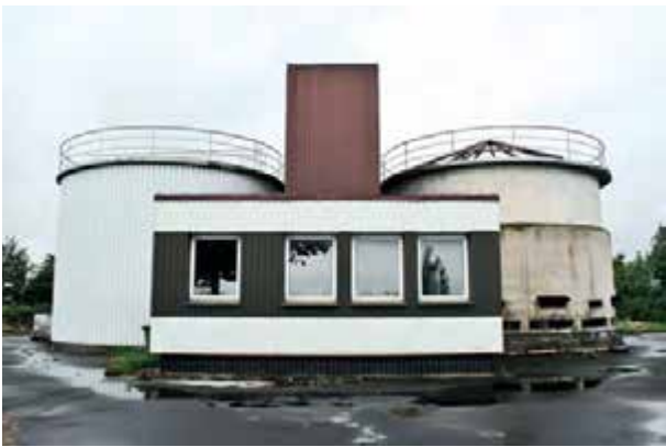
Alte Kläranlage Schwabstedt von 1965
