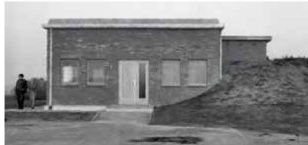
Wasserwerk I . Baustufe mit dem provisorischen Reinwasserbehälter (rechts)
