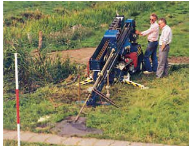
Unterbohrung per Flowtex-Verfahren
