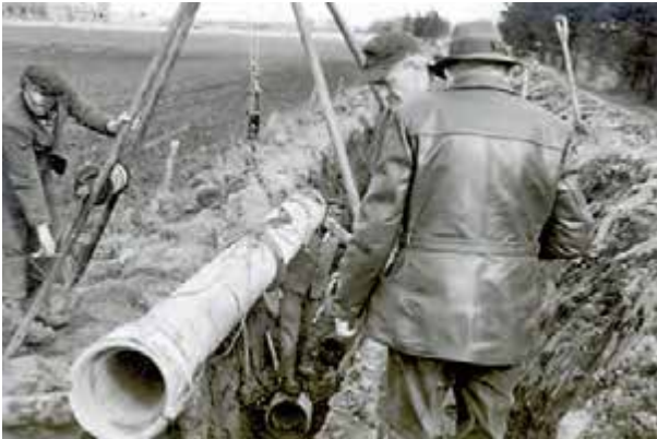
Rohrverlegung bei schwerer körperlicher Arbeit
