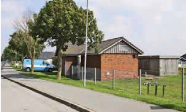
Zentrale Vakuumstation auf Nordstrand, Osterkoogsstraße/Osterdeich
