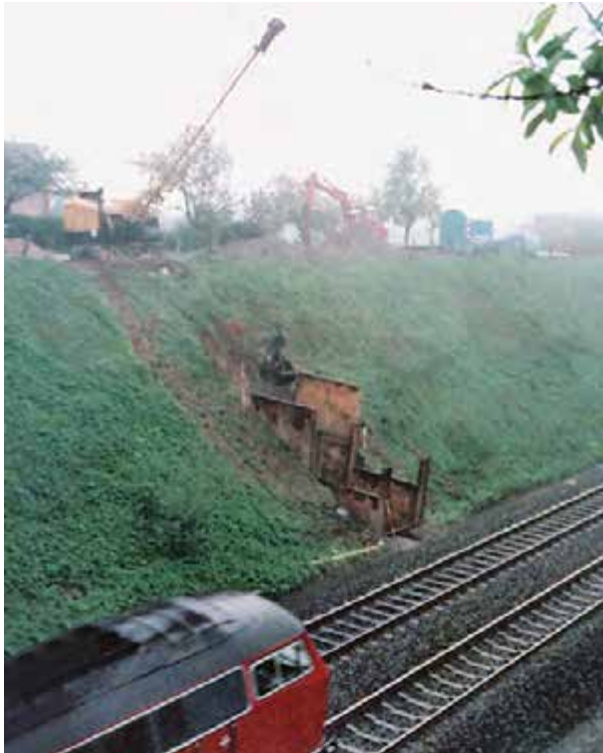
Unterbohrung der Eisenbahntrasse in Hüsbybrücke, 1984
