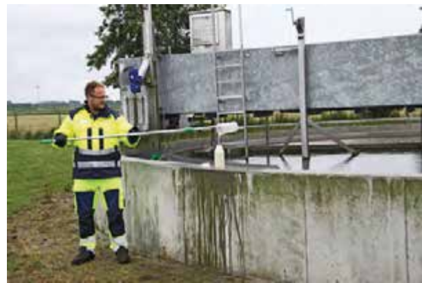
Entnahme einer Wasserprobe an der Kläranlage Hattstedt
