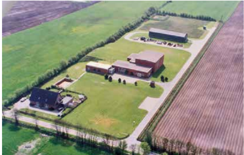
Neu- und Erweiterungsbauten auf dem Wasserwerksgelände, von unten: Doppelhaus mit den beiden Wassermeisterwohnungen, Schlammabsetz- becken, Wasserwerk mit Filterhalle und Reinwasserbehälter und Materialhalle
