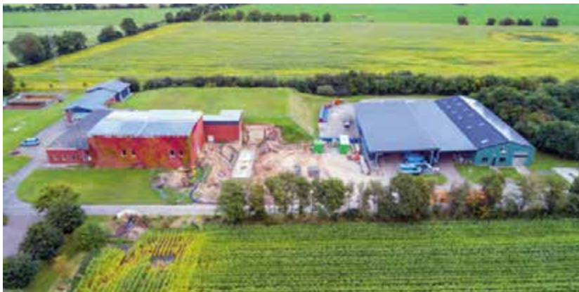
Baustelle der neuen Filterhalle zwischen Wasserwerk (links) und Materialhalle (rechts)
