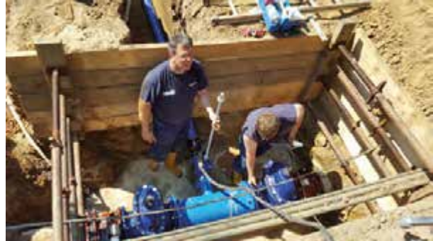
Einbindung Neubaugebiet Ostenfeld mit 19 Baugrundstücken in die vorhandene Hauptleitung, Mai 2016
