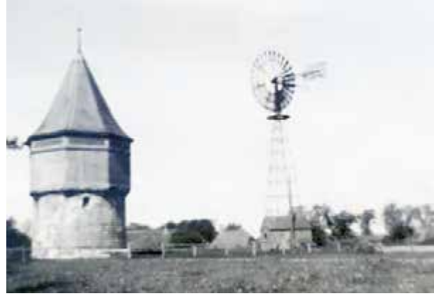
Norderstapel, Wasserturm mit Wasserwerk
