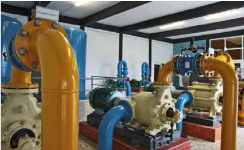
Reinwasserpumpen
