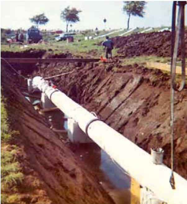
Verlegung der Trinkwasserleitung nach Hollingstedt 1973
